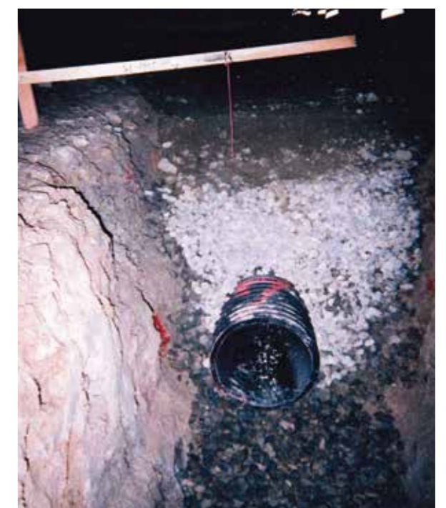
トンネル中央排水管工事
