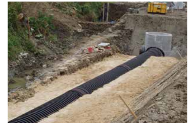
雨水排水管工事
