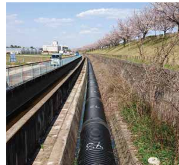
水路改修工事
