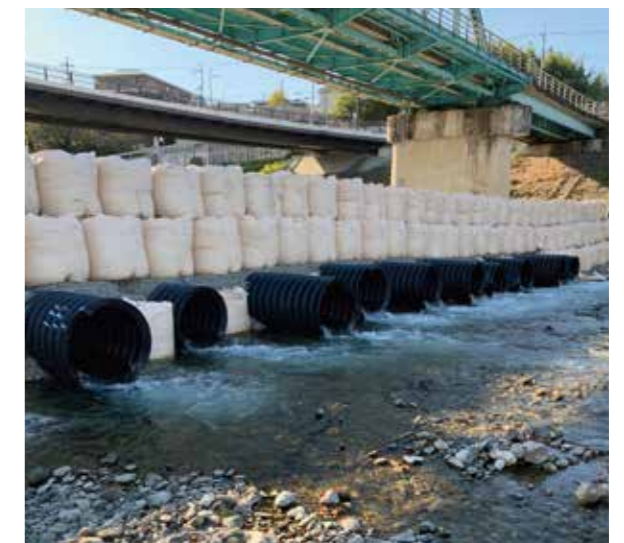
河川改修工事
