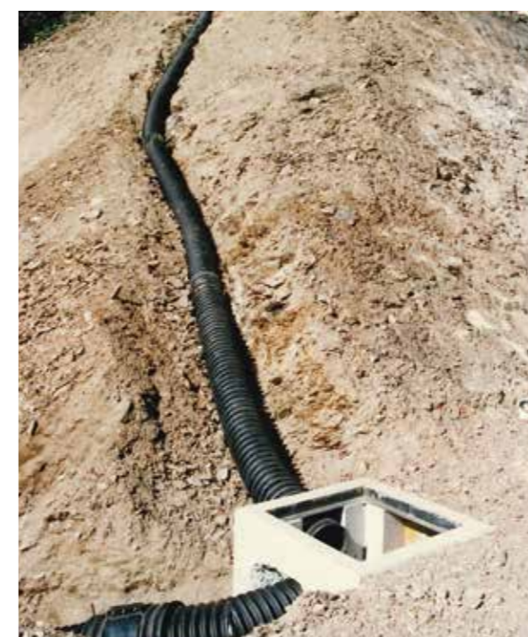
法面排水工事
